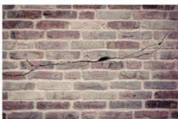
Fissura numa parede antiga
