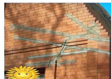
Riss in neu gebauter Ziegelwand
